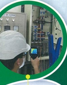
電力盤熱點量測
